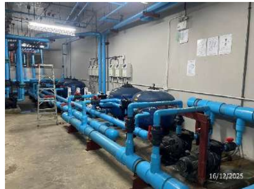
รูปที่ 60 ระบบกรองสระว่ายน้ำ
