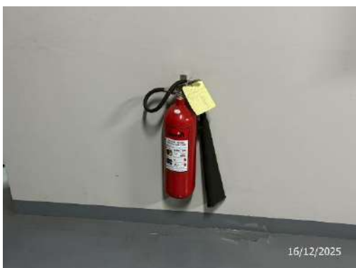
รูปที่ 83 ถังดับเพลิงเคมี พร้อมป้ายแนะนำการใช้อุปกรณ์
