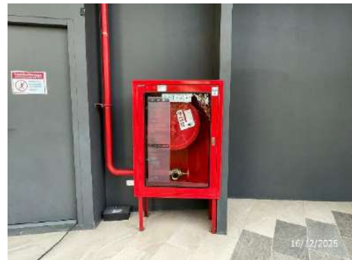
รูปที่ 82 ตู้เก็บสายฉีดน้ำดับเพลิง และป้ายแนะนำการใช้อุปกรณ์
