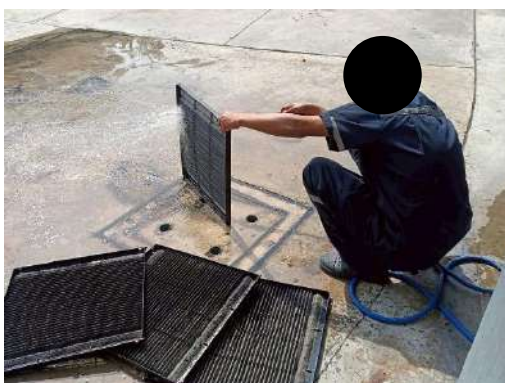
รูปที่ 77 การล้างแผ่นกรองอากาศของเครื่องปรับอากาศ
