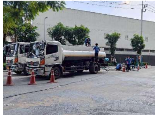
รูปที่ 30 การตั้งกรวยยาง ขณะสูบตะกอน หรือเปิดฝาเพื่อเก็บไขมันหรือเก็บตัวอย่างน้ำ
