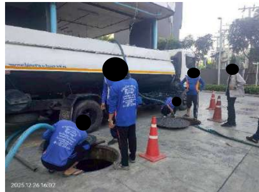
รูปที่ 32 บริษัทเอกชนที่ได้รับอนุญาตจากกรมโรงงาน อุตสาหกรรม เข้ามาสูบตะกอนส่วนเกิน
