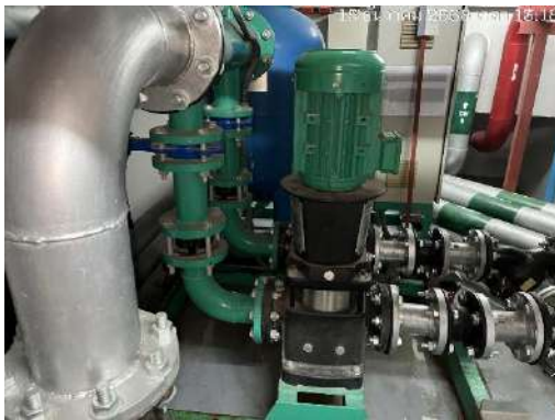
รูปที่ 47 ระบบสูบน้ำใช้ในอาคาร
