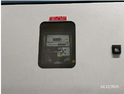
รูปที่ 35 ระบบมิเตอร์ไฟฟ้าสำหรับระบบบำบัดน้ำเสีย
