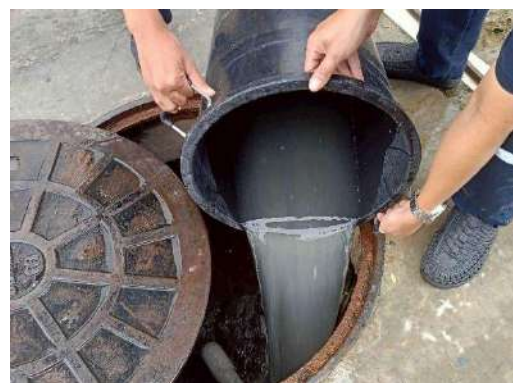
รูปที่ 28 การเติมเชื้อจุลินทรีย์
