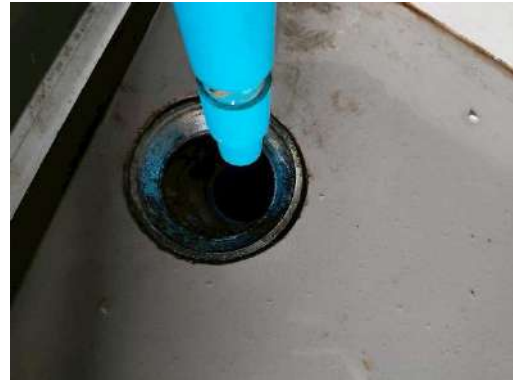
รูปที่ 42 ท่อรวบรวมน้ำเสียของห้องพักมูลฝอย
