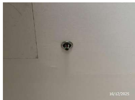
รูปที่ 84 ระบบหัวกระจายน้ำดับเพลิงอัตโนมัติ
